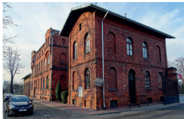
Budynki administracyjne gazowni na Woli. Fot. P. Stryczyński
