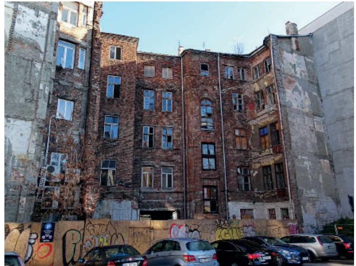
Kamienica – konstrukcja ceglana ul. Mokotowska 2, fot. P. Stryczyński
