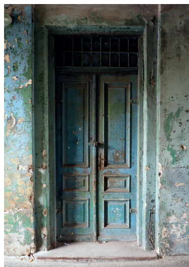
Drzwi wejściowe na klatkę schodową kamienica ul. Marcinkowskiego 9
